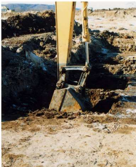
ビバメルト散布域での掘削 (容易に掘削できた)
