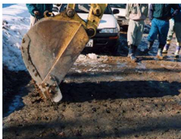
ピバメルト散布 （注入方式 30L/m 2 ）
