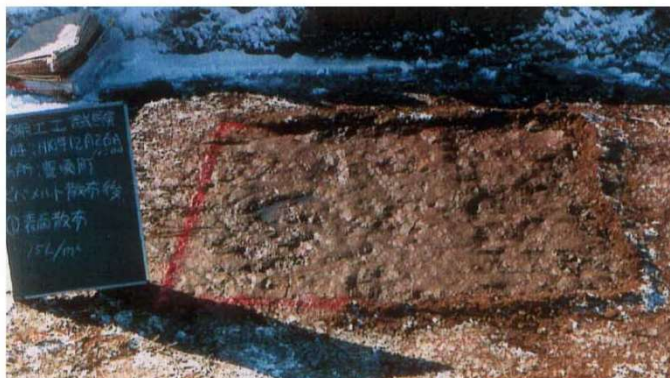
未凍結地盤へのピバメルトの散布 (15L/m 2 )
