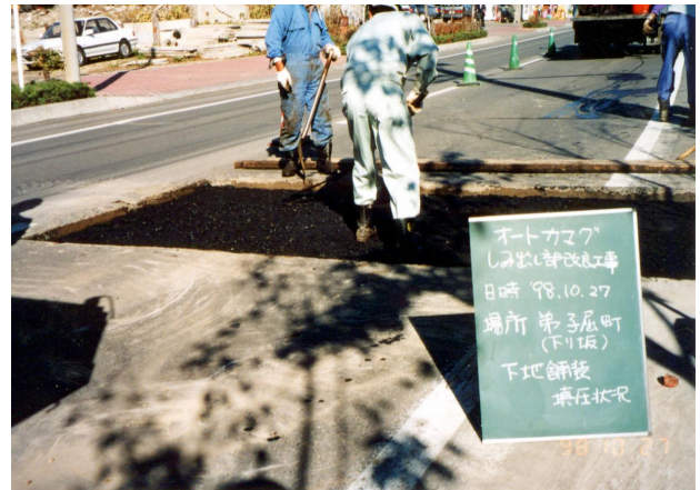
4. 下地アスファルト充填
