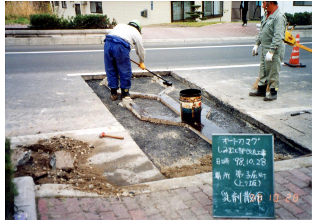
10. 木枠外し及び乳剤散布
