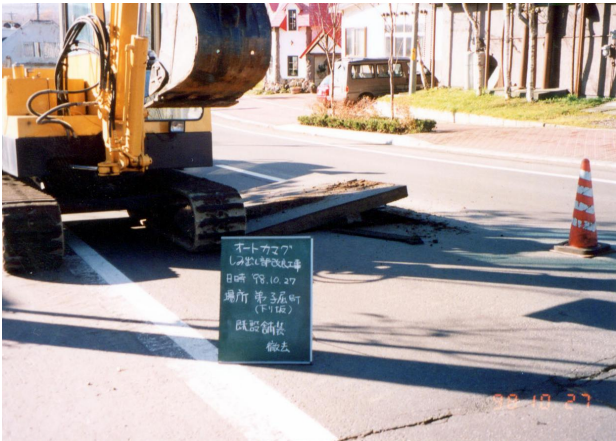
1. 既設舗装撤去
