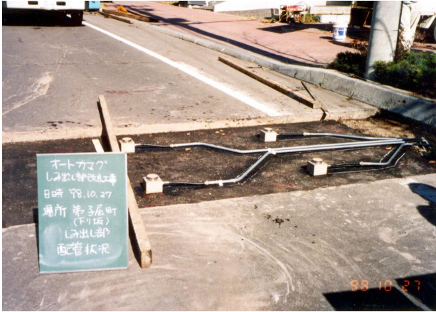
8. 配管接続完了
