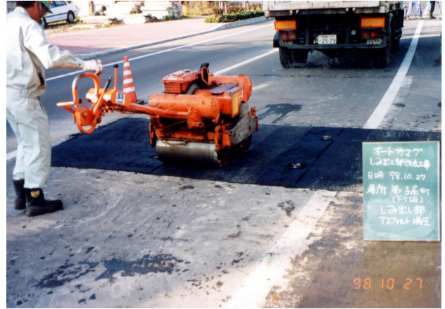
11. アスファルト充填及び填圧
