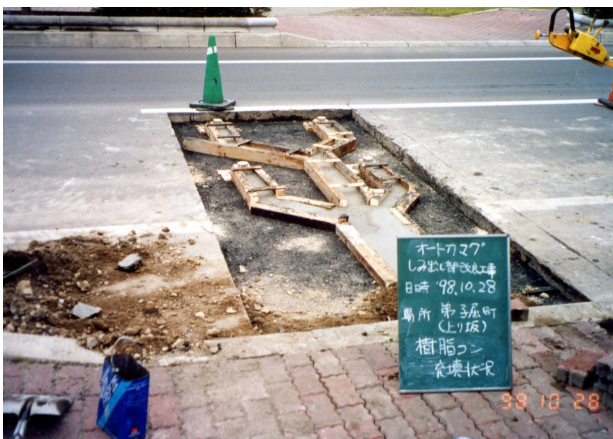
10. 樹脂コン充填及び硬化
