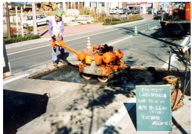
5. 下地舗装填圧
