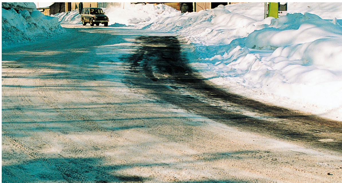
カマグ使用の路面状況
