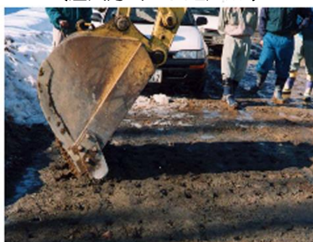
ピバメルト散布 （注入方式 30L/m 2 ）
