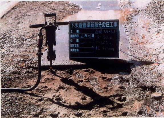
ブレーカーによる注入孔の形成
