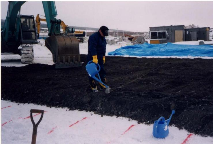
埋め戻し土砂へのピバメルトの散布
