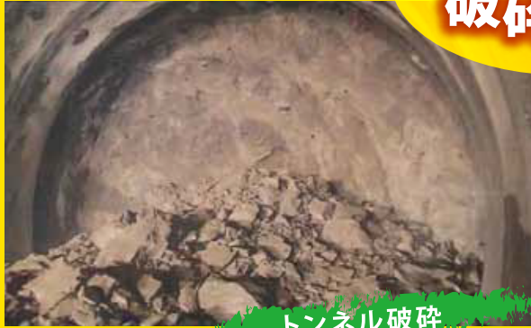
トンネル破碎
