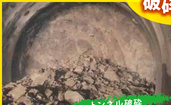
トンネル破碎
